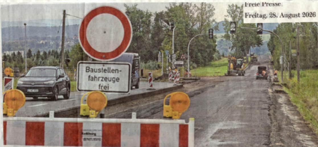
Der Autobahnzubringer S 283 bei Wildenfels wird gebaut. Doch auf einen straßenbegleitenden Radweg in Richtung Reinsdorf müssen Radfahrer und Fußgänger weiter warten.
